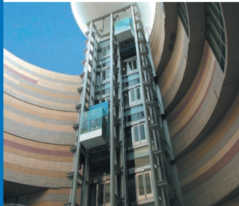
なんばパークス向け 屋外型展望用エレベーター 囲いのないオープン昇降路により、ビルが演出する音・光・映像との一体化を実現し、「見(観)せるエレベーター」として話題を集めています。
